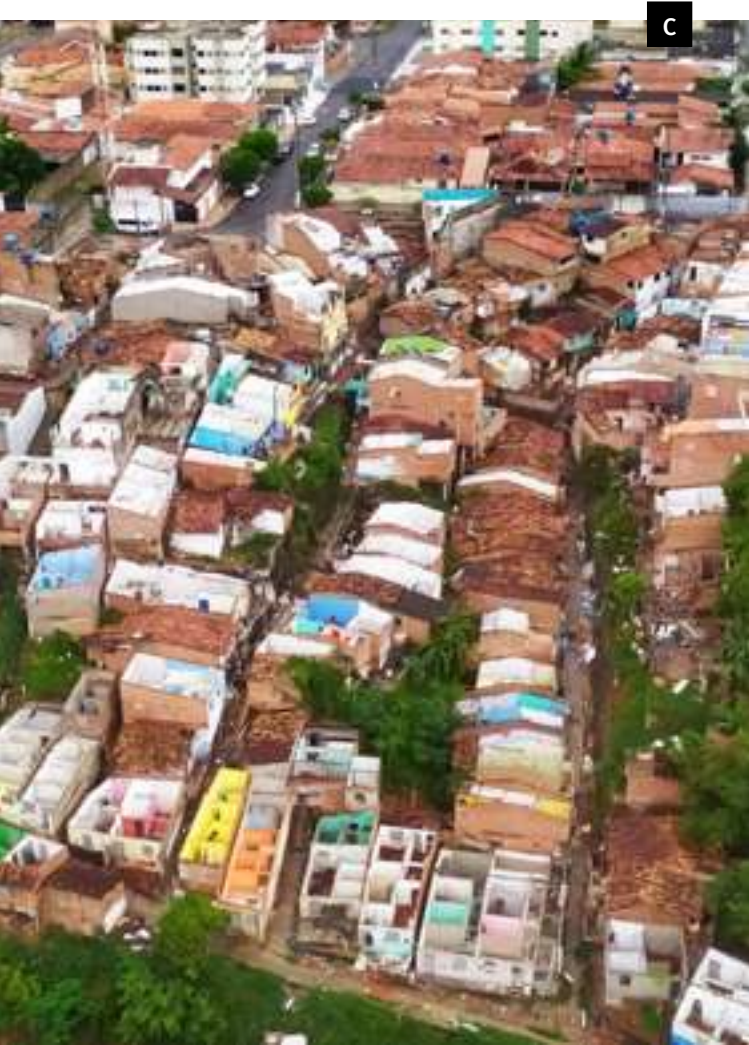
Fotos: Defesa Civil do Município de Maceió (2019).
