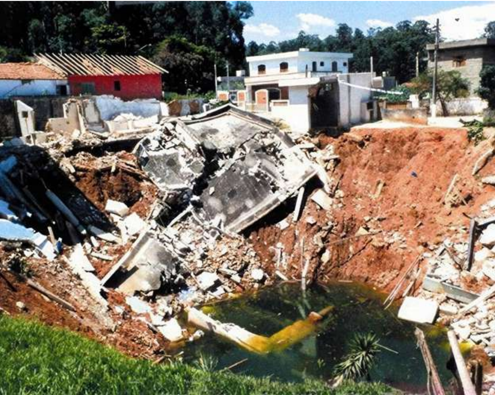
Figura 69 – Cratera de colapso no município de Cajamar/SP.
