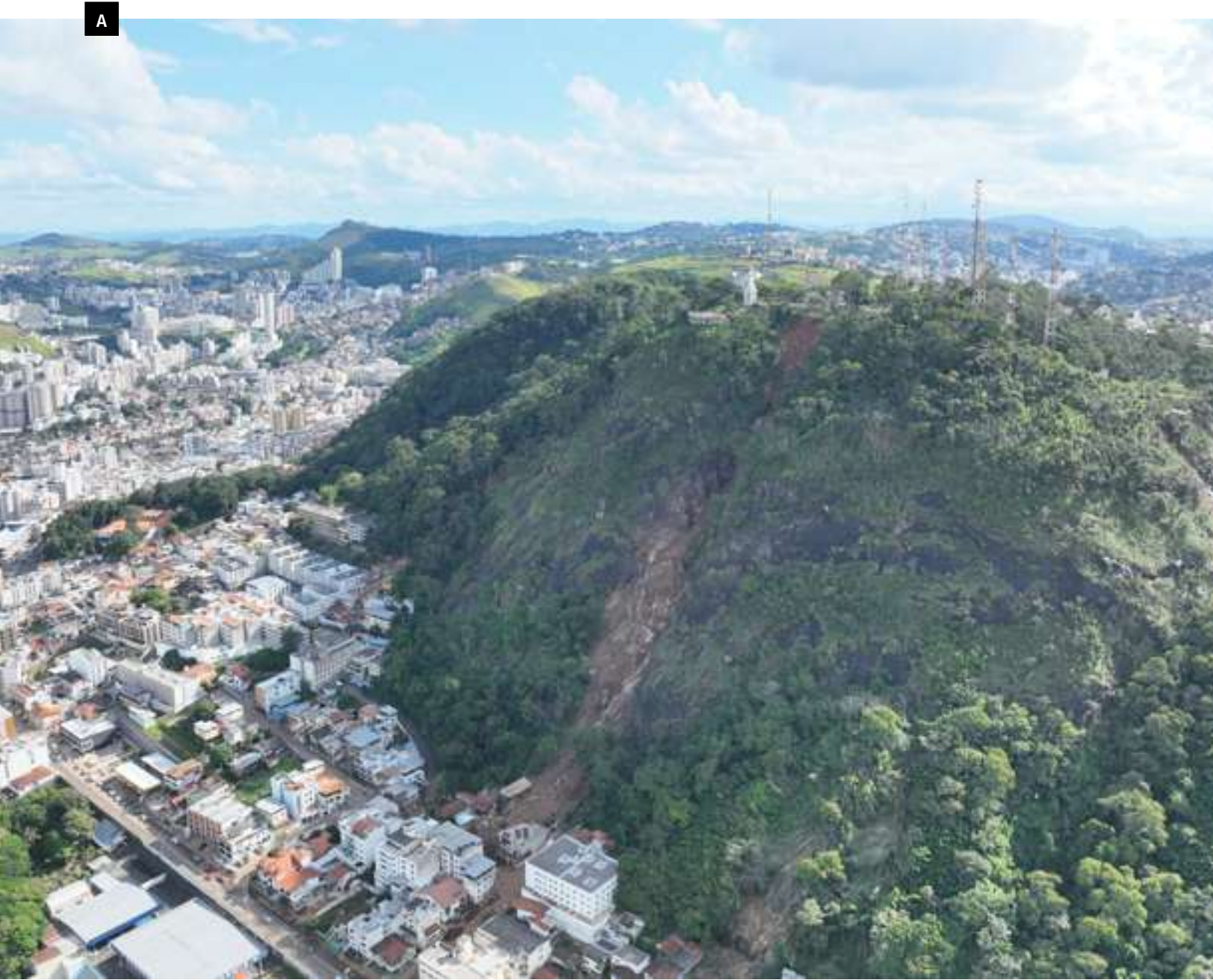
Figura 98 – Dinâmica de movimentos complexos condicionados por linhas de descontinuidade no Morro do Cristo, Juiz de Fora/MG.
