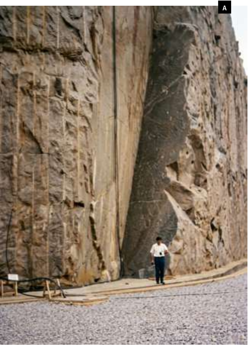
Figura 56 – Deslizamento em cunha na Serra da Mesa /GO (A), e em Nova Lima/MG (B).
