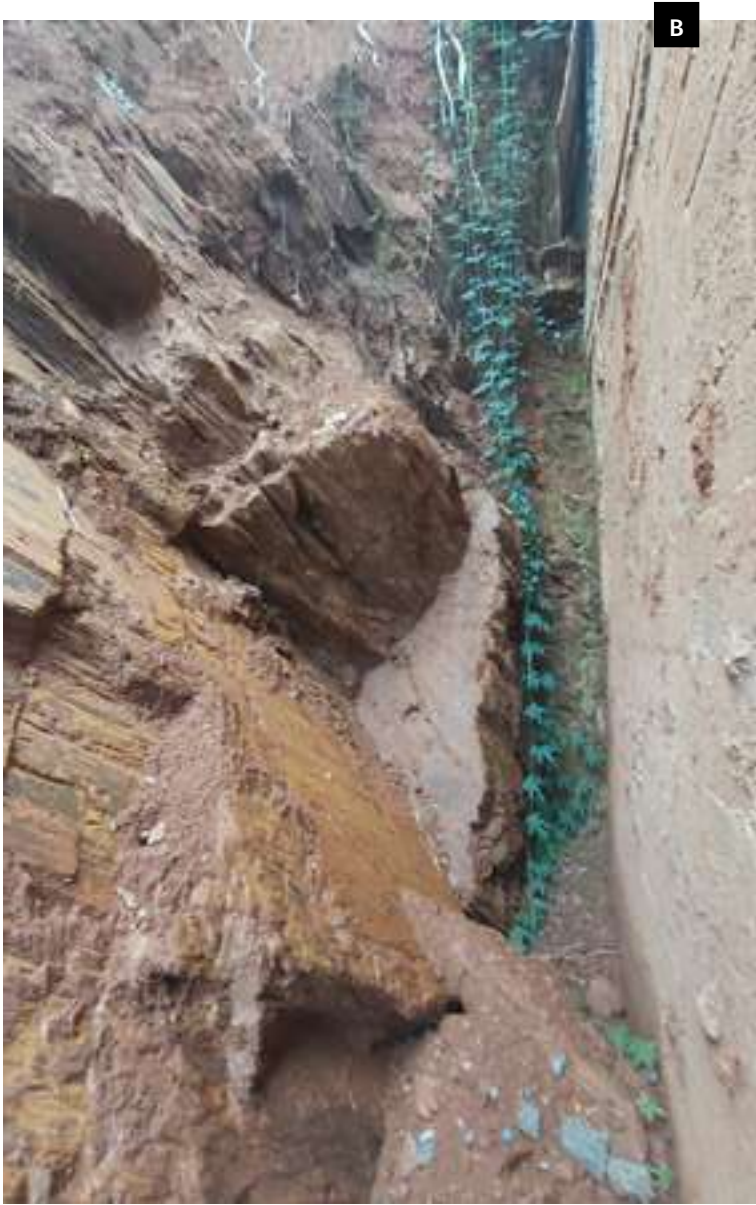
Figura 56 – Deslizamento em cunha na Serra da Mesa /GO (A), e em Nova Lima/MG (B).
