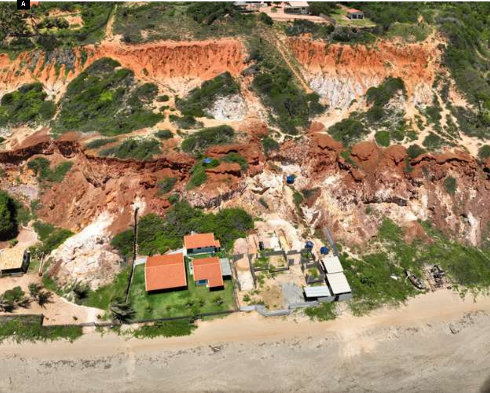
Figura 73 – Processos erosivos lineares, queda e rolamento de blocos e deslizamentos em trecho da Praia de Peroba, Icapui/CE (A); queda e rolamento de blocos e deslizamentos provocados pela erosão costeira na base da falésia, na mesma praia (B).
