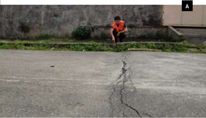
Figura 71 – Registros do processo de subsidência induzida em Maceió/AL: evidências de instabilidade no terreno e estruturas nos bairros de Pinheiro e Mutange, que afetaram cerca de 60 mil pessoas (A e B); edificações abandonadas devido ao risco muito alto de colapso estrutural (C).
