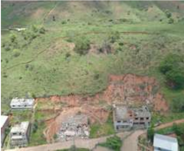
B Trincas no terreno e degraus de abatimento – Ponte Nova/MG, 2024.
