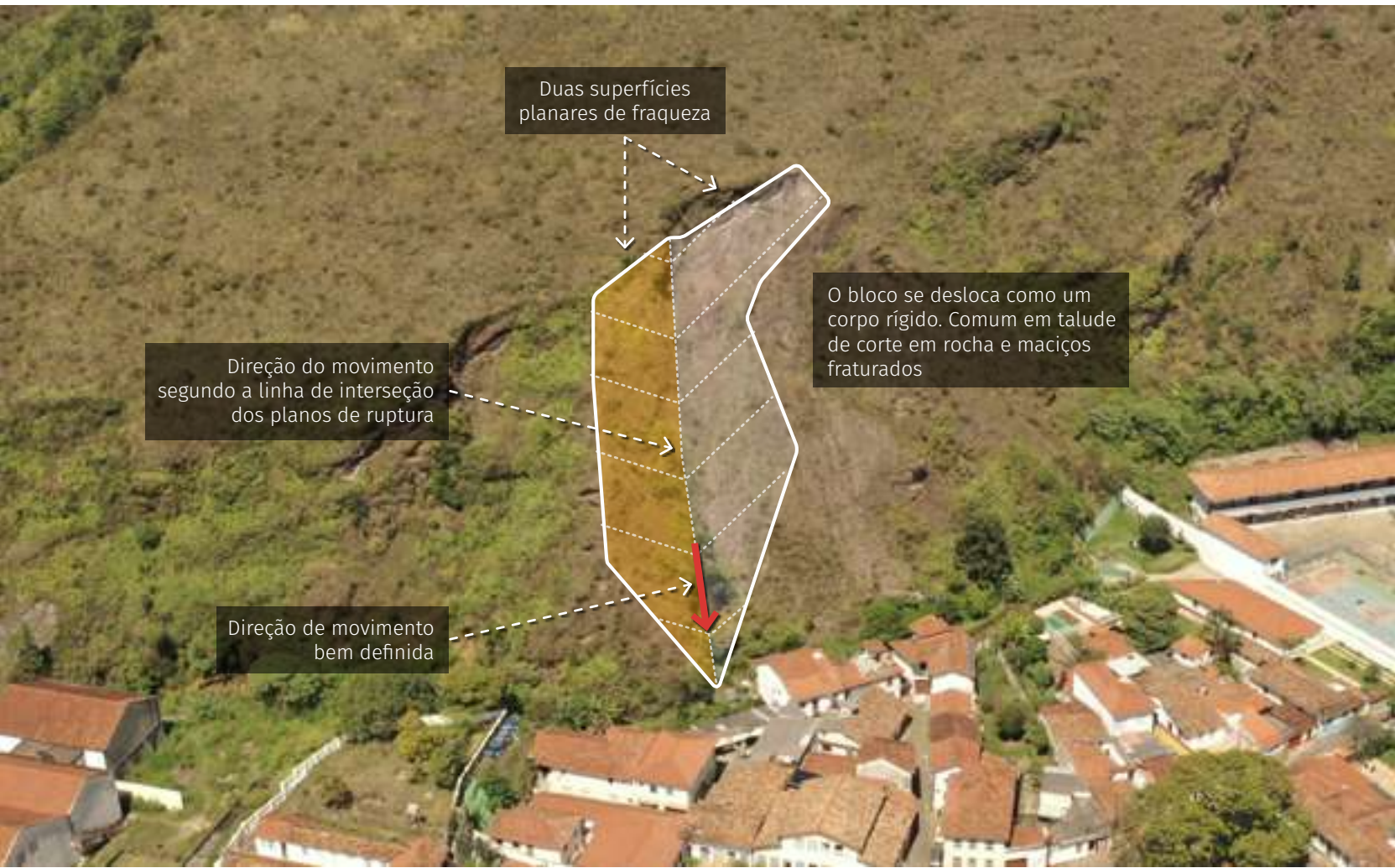
Figura 55 – Deslizamento em cunha ou estruturado na cidade de Ouro Preto/MG.
