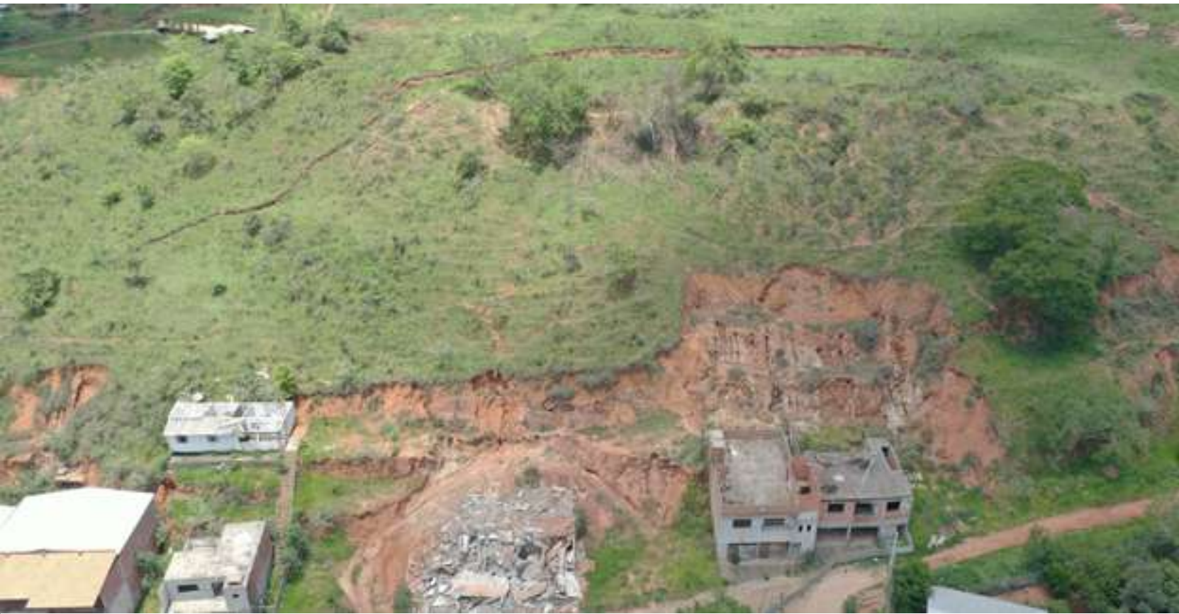
Figura 54 – Superfície de ruptura de deslizamento rotacional de grande porte. Bairro Progresso, município de Ponte Nova/MG.
