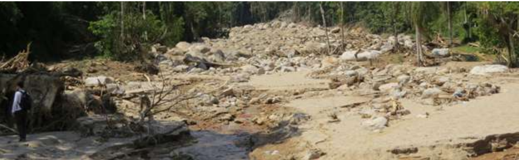
Figura 67 – Trecho intensamente afetado pela passagem do debris flow no ribeirão Guarda-Mão, município de Itaoca/SP.
