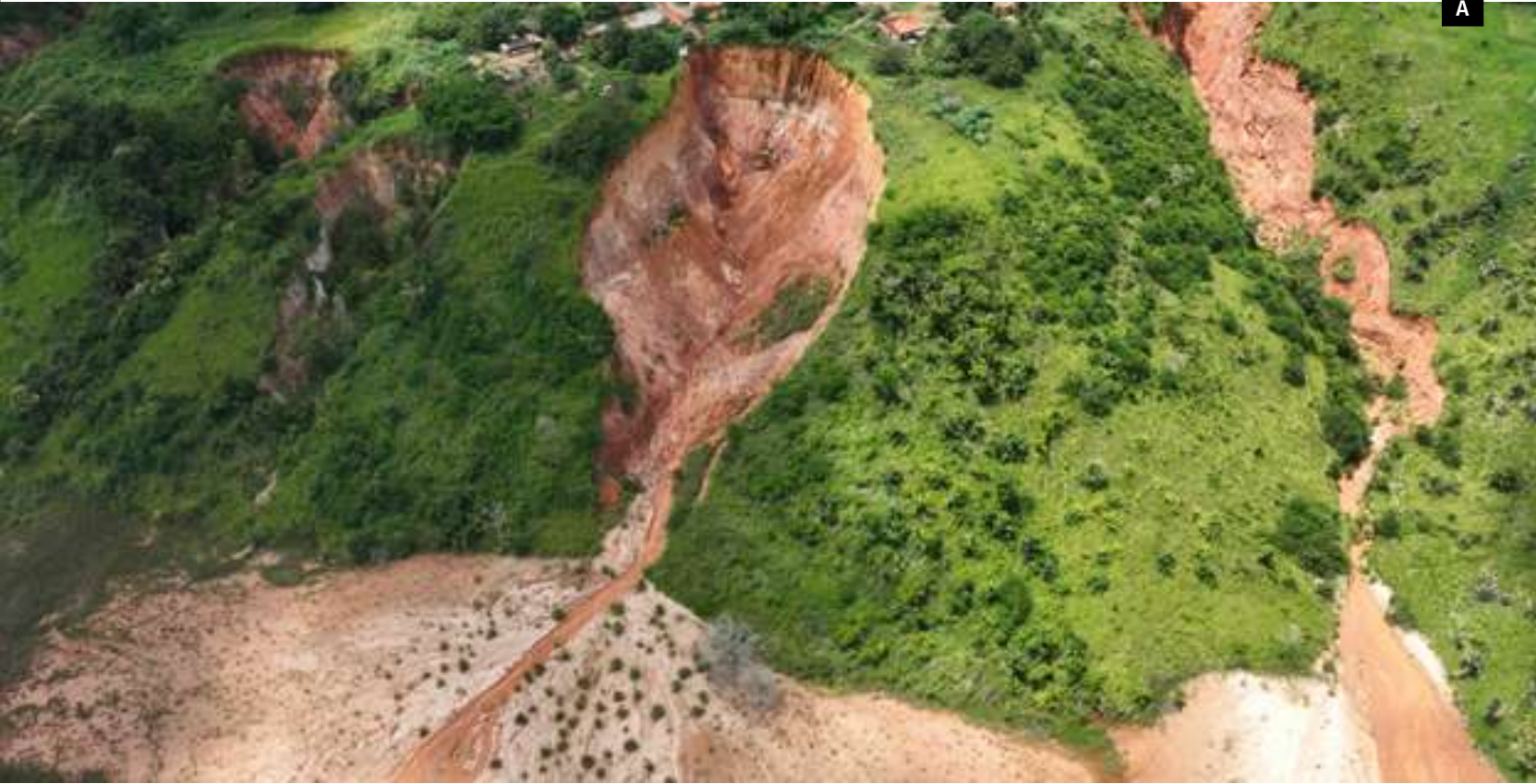
Figura 30 – Processos erosivos do tipo voçoroca no município de Buriticupu/MA (A e B) e no município de Açailândia/MA (C).
