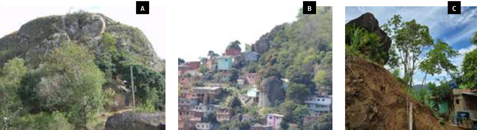
Figura 60 – Bloco rochoso instável. Morro do Jaburu, Vitória/ES (A); Bloco rochoso de grande porte estabilizado no Bairro Jaburu, Vitória/ES (B) e Bloco rochoso a montante de edificação de baixo padrão construtivo no Município de Vargem Alegre/MG (C).
