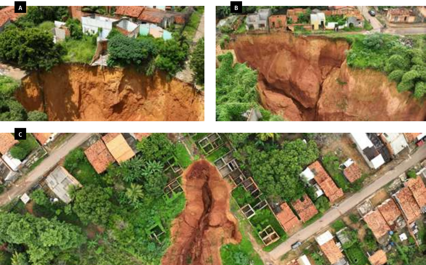
Figura 40 – Área classificada como de Risco Muito Alto. Voçoroca em área periurbana do município de Buriticupu/MA.
