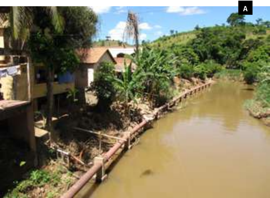
Figura 35 – Solapamento de margem de canal fluvial no Rio Guandu, Afonso Cláudio/ES – Risco Alto (A); no Rio Doce, Colatina/ES – Risco Muito Alto (B) e no Rio Ubá, Ubá/MG – Risco Muito Alto (C).
