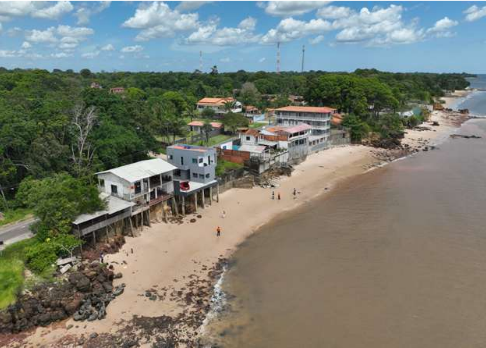
Figura 33 – Erosão flúviomarinha na Praia do Paraíso, Ilha do Mosqueiro, Belém/PA.
