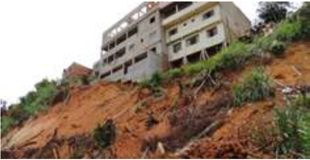
A Edificações de bom padrão construtivo – Colatina/ES.
