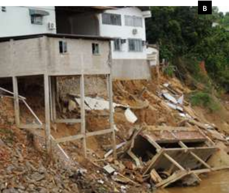
Figura 35 – Solapamento de margem de canal fluvial no Rio Guandu, Afonso Cláudio/ES – Risco Alto (A); no Rio Doce, Colatina/ES – Risco Muito Alto (B) e no Rio Ubá, Ubá/MG – Risco Muito Alto (C).
