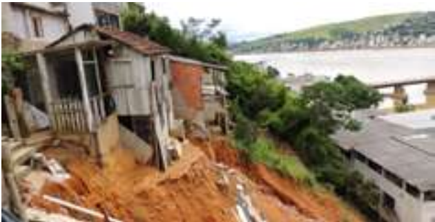
D Edificações de baixo padrão construtivo – Colatina/ES.
