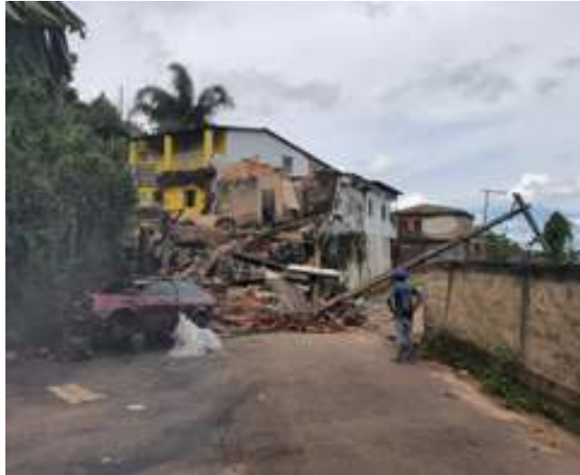
F Colapso de estruturas e postes inclinados – Ouro Preto, 2022.
