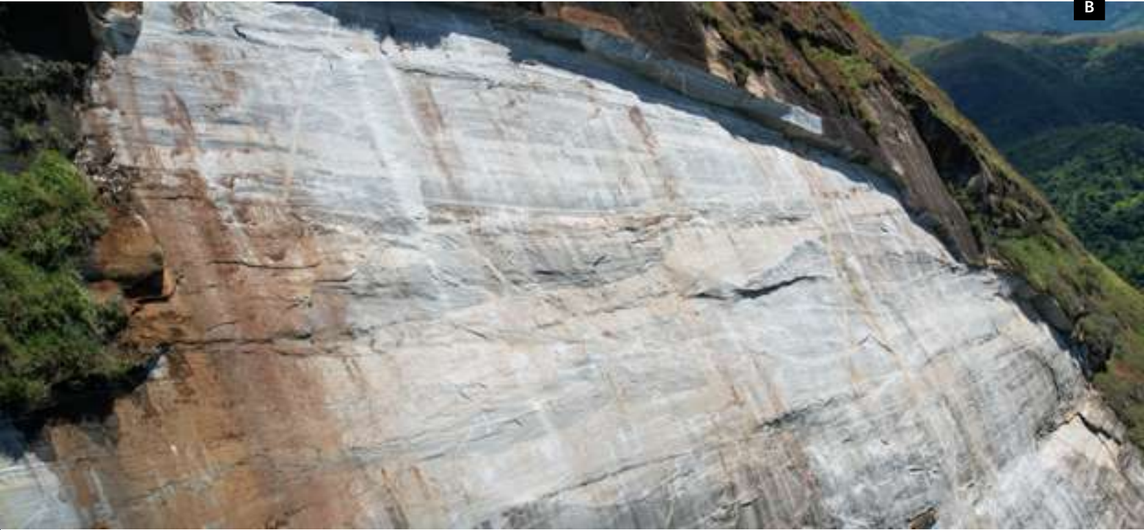
Fotos: Thalweg Tecnologia e serviços de Geotecnia, 2025.
