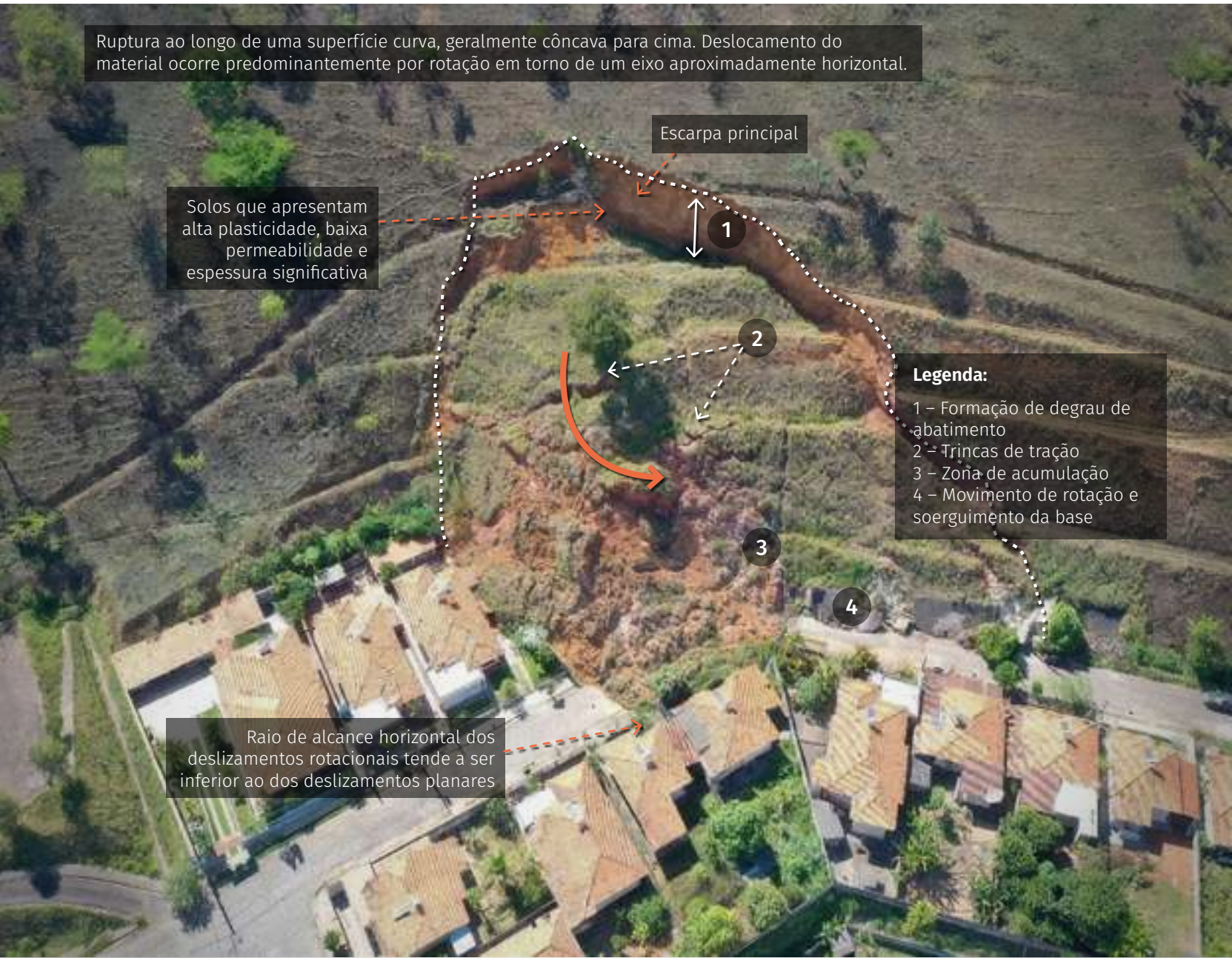
Figura 53 – Registro de deslizamento rotacional em talude no distrito de São Sebastião do Soberbo, Santa Cruz do Escalvado/MG.
