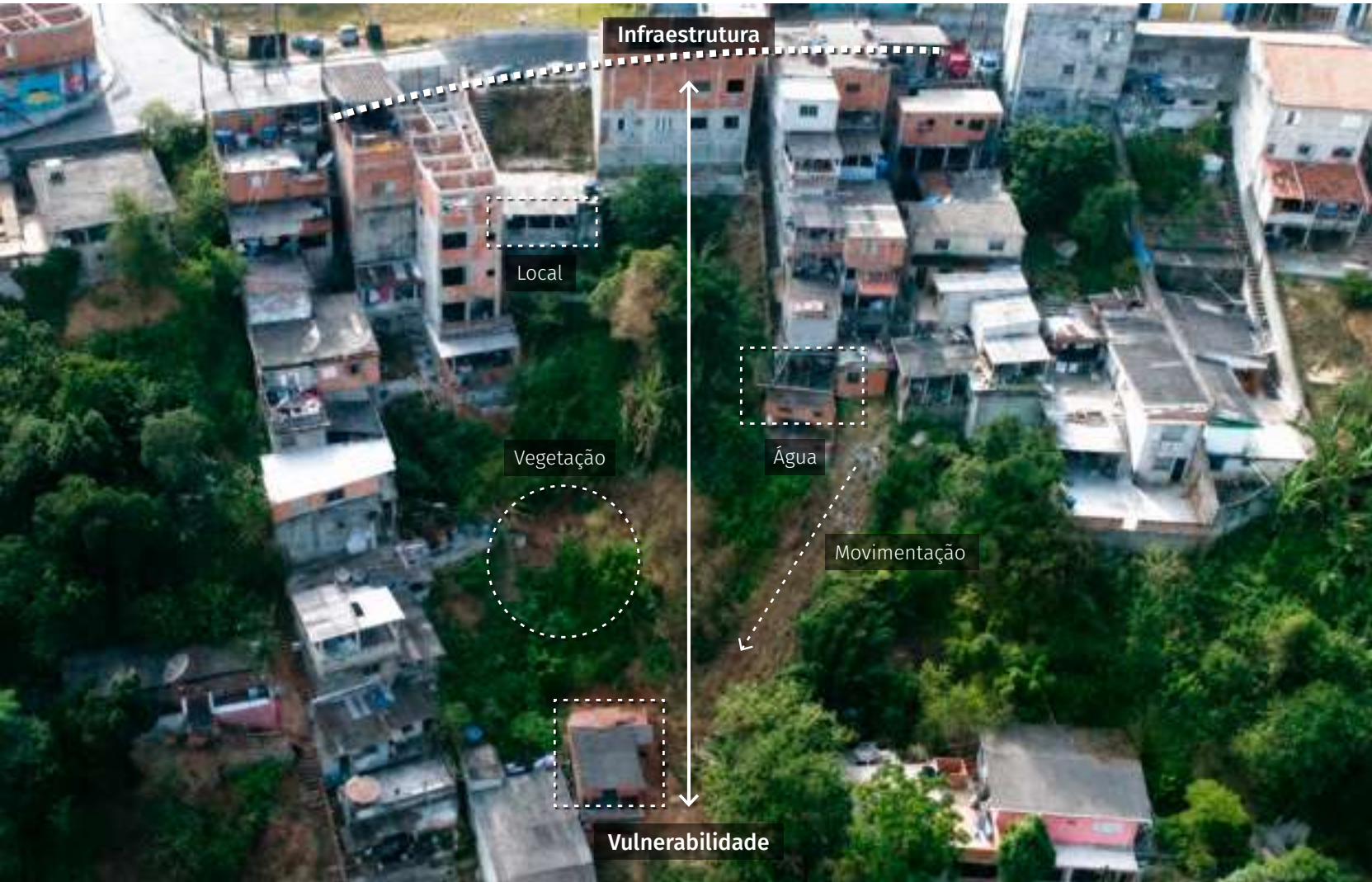
Figura 77 – Exemplo de elementos observáveis em campo para a avaliação e caracterização de um setor de risco.
