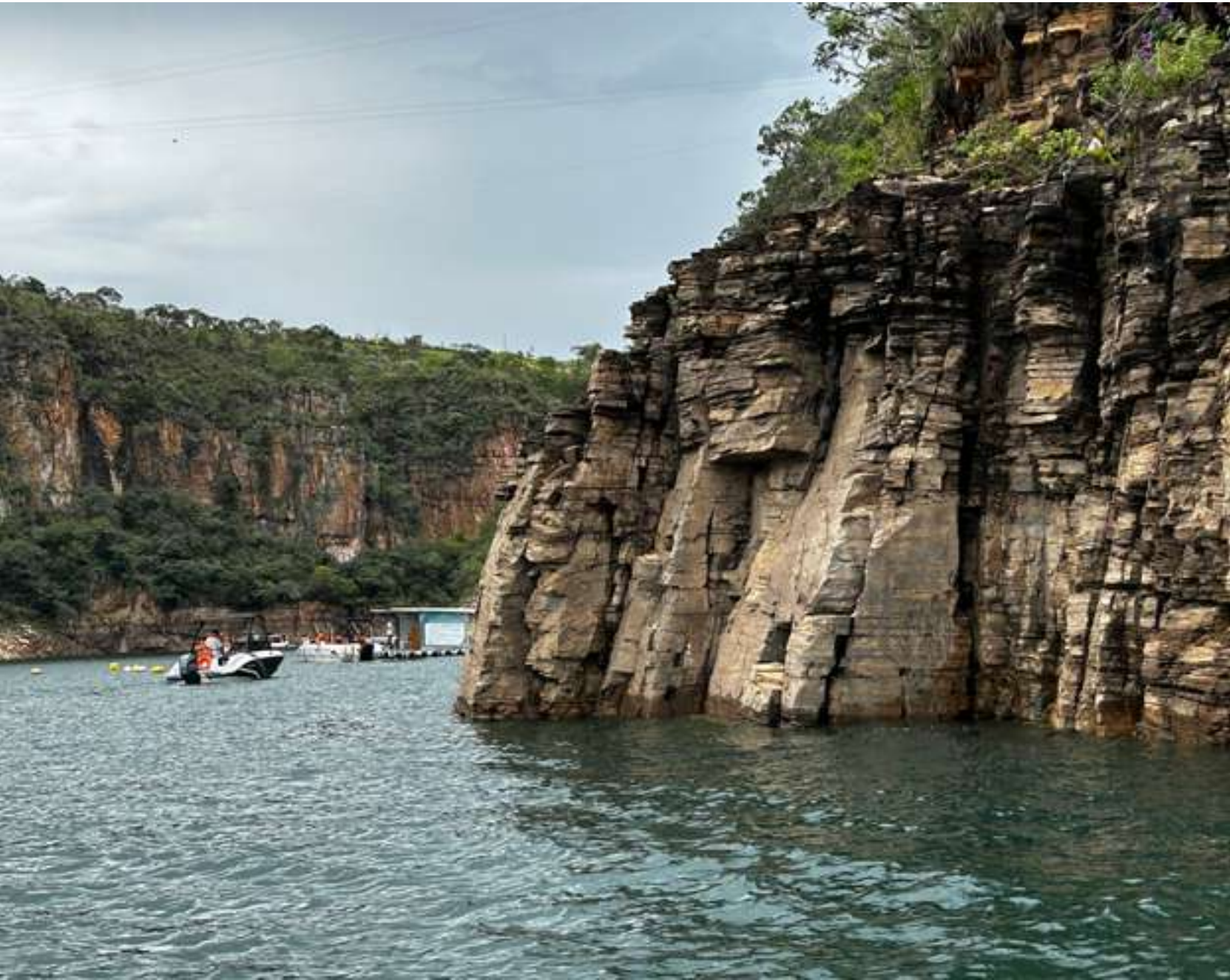
Figura 62 – Suscetibilidade a ocorrência de queda e tombamento de rochas no município de Capitório/MG.
