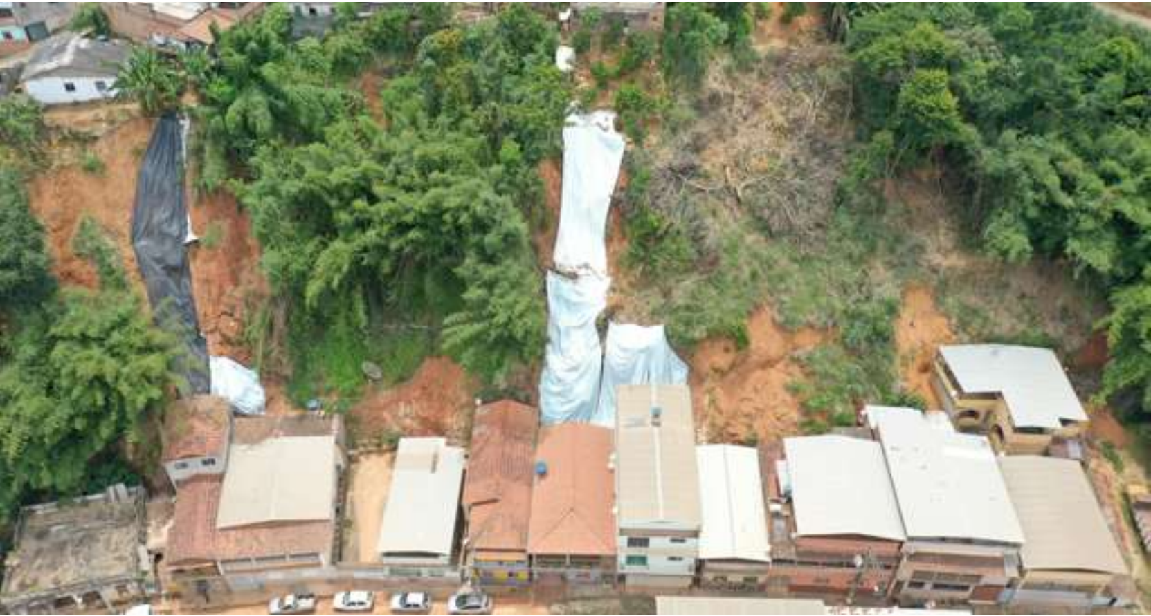
Figura 50 – Deslizamentos translacionais rasos, no município de Barra Longa/MG.
