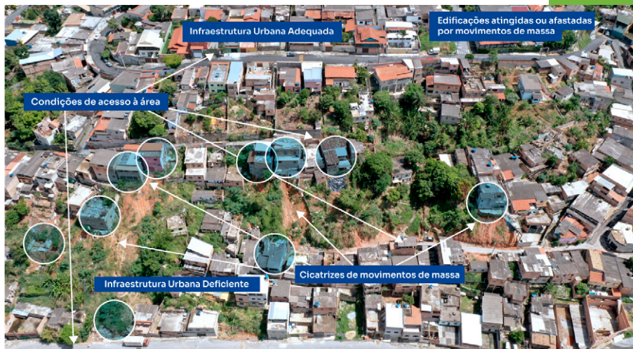
Figura 7. Exemplo de interpretação da imagem para extração de elementos que devem ser observados em campo para a caracterização de um setor de risco.
