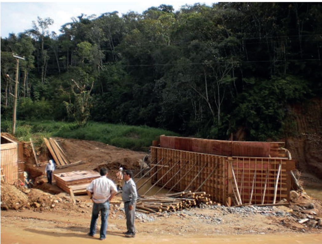
Inspeção e relatório de estrutura sendo reabilitada: área rural de cidade do Vale do rio Itajaí-Açu/SC.
