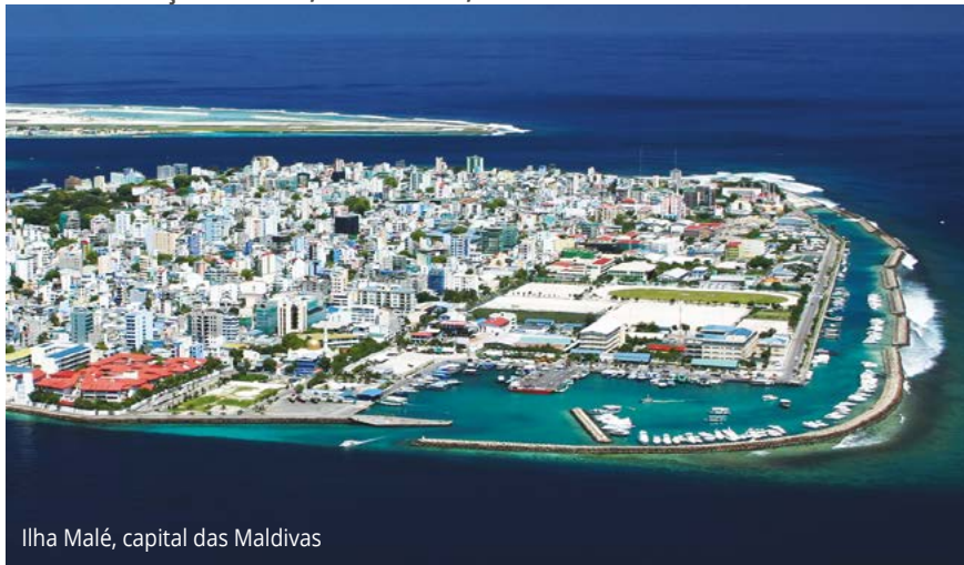
FOTO 24 &gt; PROTEÇÃO COSTEIRA, ILHA DE MALÉ, MALDIVES
