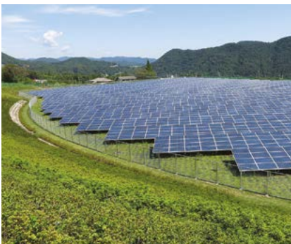
Fazenda de energia solar, cidade de Aikawa, Japão
