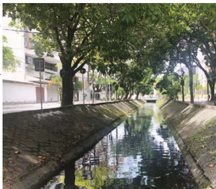
Canal de drenagem no Jardim Botânico, Rio de Janeiro, 2021.
