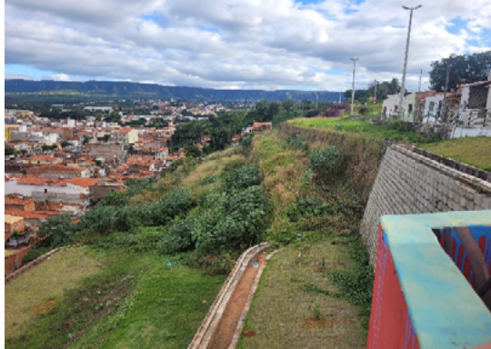
Figura 2: Encosta do Seminário
