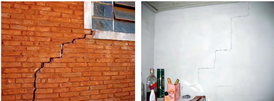
**Figura 6.1** - Ocorrências de trincas e fissuras nas edificações causadas por colapsos de solo (Fontes: Rodrigues, 2007 e Acervo IG-SMA, 2009).
