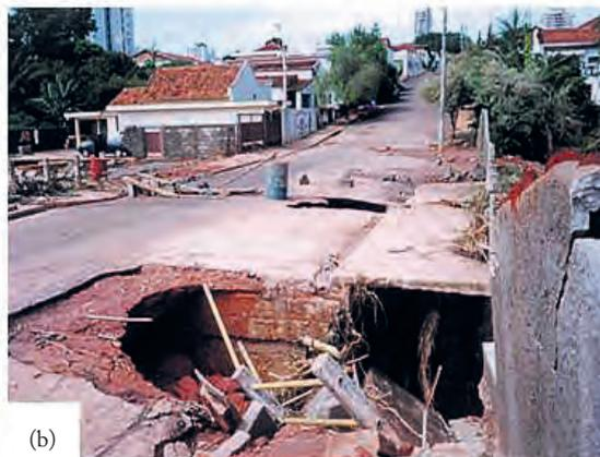
**Figura 10.5** - Mapeamento de risco associado a inundação no município de Jaboticabal, SP: (a) Setorização e classificação das áreas de risco (IG, 2005); (b) detalhe da ruptura do sistema de águas pluviais ocorrido em 1999, em consequência de evento de inundação (Fonte: Acervo PM Jaboticabal).
