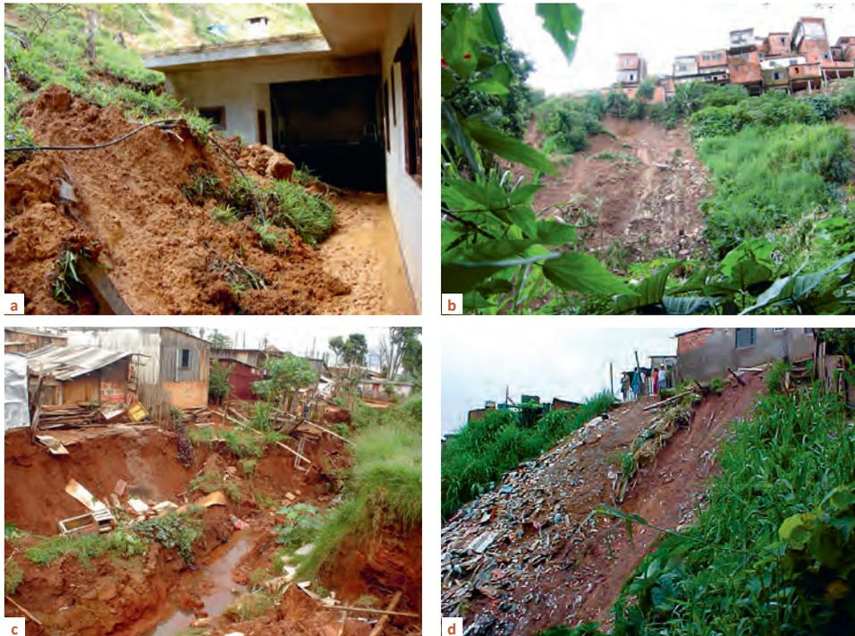
**Figura 2.12** - Exemplos de situações que devem ser evitadas: (a) construção de moradias muito próximas ao talude de corte em Jaraguá do Sul, SC, 2008; (b) moradias na crista de talude com altura e inclinação excessiva em Osasco, 2006; (c) construção em margens de córregos em Itapeva, 2007; (d) lançamento e acúmulo de lixo no talude ou encosta em São Bernardo, 2005. Fonte: Acervo IG.
