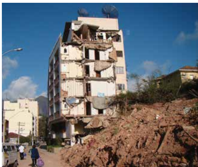
Chuva em Nova Friburgo - RJ, 2011. Lateral de edifício é atingido por escorregamento de rochas e solo.
