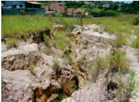
Erosão em área urbana de São José dos Campos (Fevereiro de 2011). Foto: Acervo IG.
