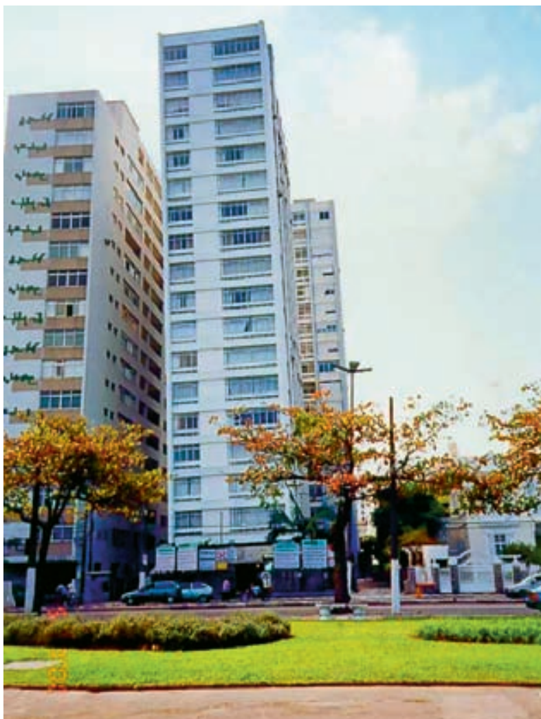
Edifícios residenciais na orla de Santos/SP. O edifício na posição central está inclinado em função do recalque da superfície. Foto: Acervo IG.
