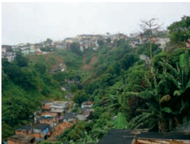
Moradias instaladas em cabeceira de drenagem com alta declividade em Franco da Rocha (Janeiro de 2010). Foto: Acervo IG.
