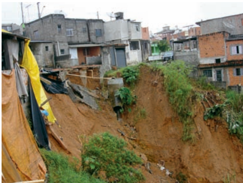
Escorregamento induzido por despejo de tubulação de água pluvial em Franco da Rocha (Janeiro de 2010). Foto: Acervo IG.
