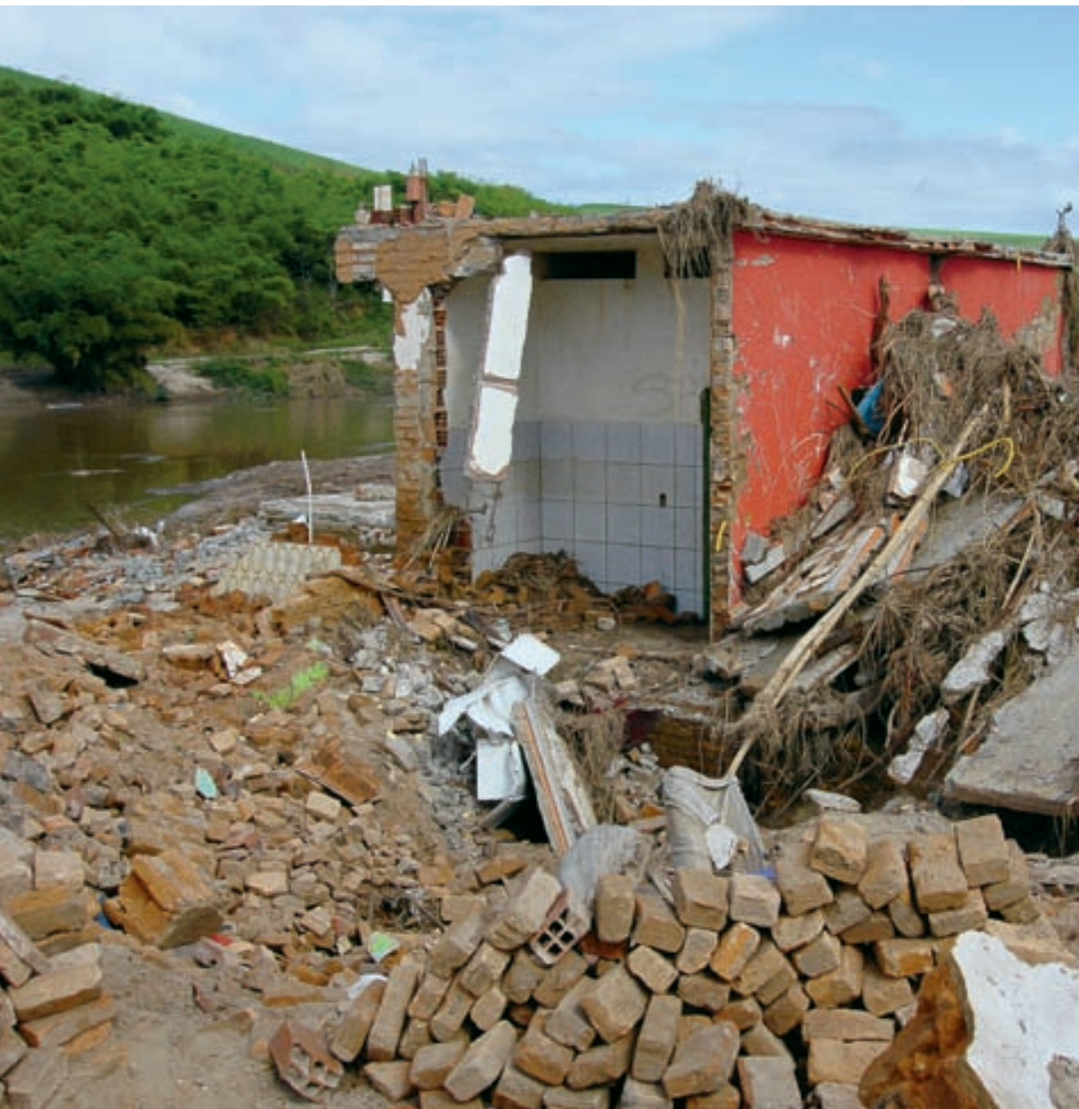
Moradia atingida por inundação em Branquinha (AL). Foto: Acervo IG
