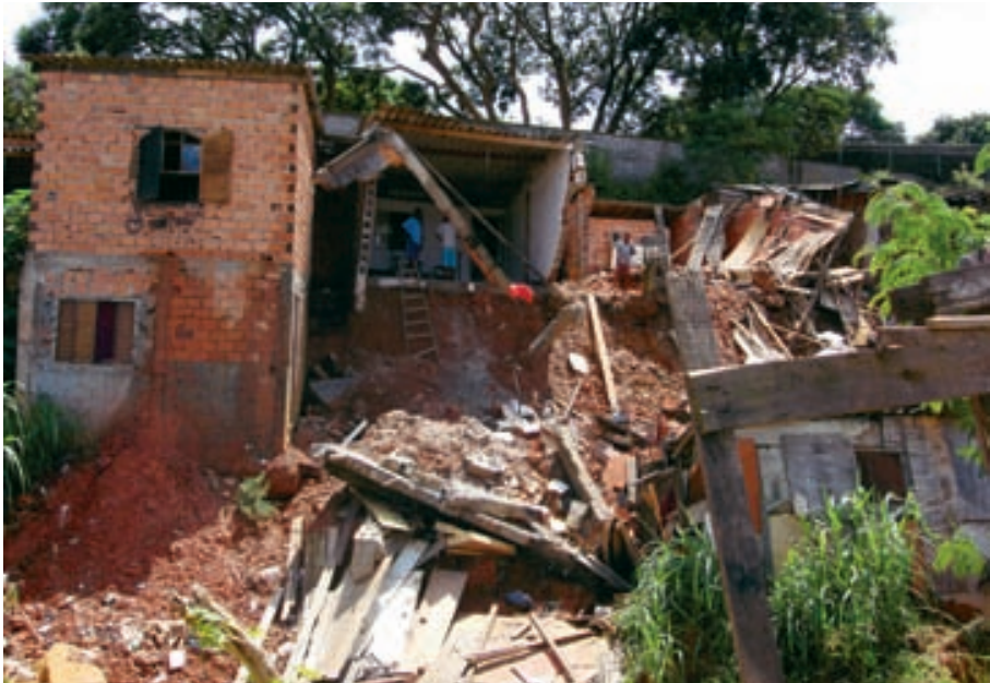
Escorregamento em Carapicuíba (Janeiro de 2010). Foto: Acervo IG.
