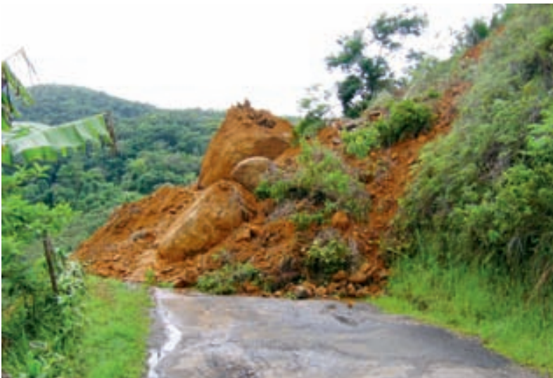
Escorregamento de solo e queda de blocos em Ubatuba (Dezembro de 2009). Foto: Acervo IG.
