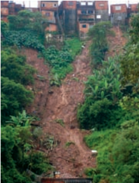
Escorregamento ameaça estabilidade das moradias no topo e na base da encosta em São Bernardo do Campo (Janeiro de 2010). Foto: Acervo IG.
